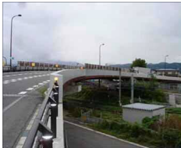
跨線橋（鉄道を跨ぐ橋梁）の例
