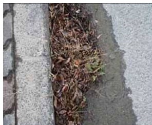
排水柵への土砂堆積
