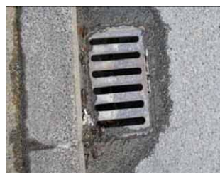
清掃による土砂の除去
