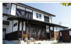
※[木部表しの庇の例] 木の構成を隠さずそのまま表して見せること。
