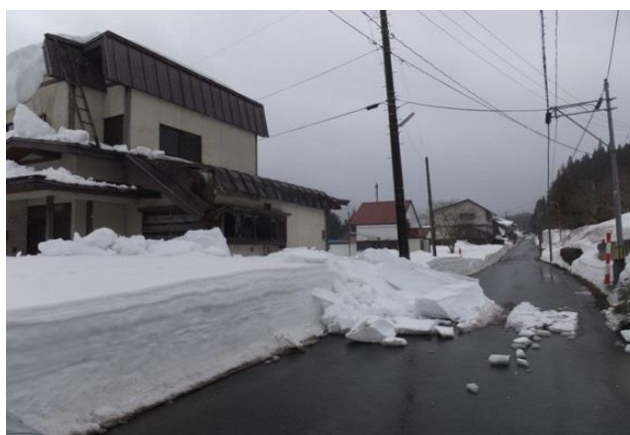
空き家からの落雪
