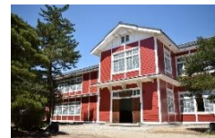
旧長井小学校第一校舎
