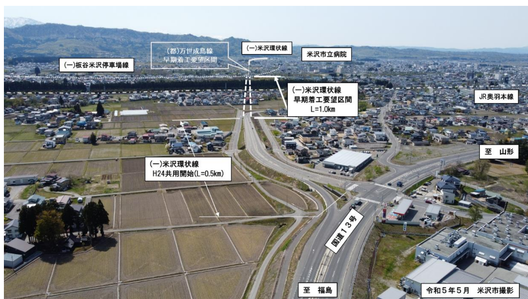
平成24年度に供用が開始された万世地区の区間
