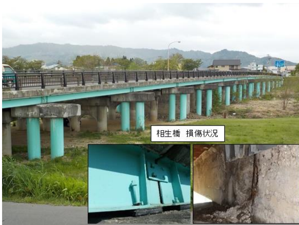
早期着工が求められる一般県道板谷米沢停車場線の相生橋
