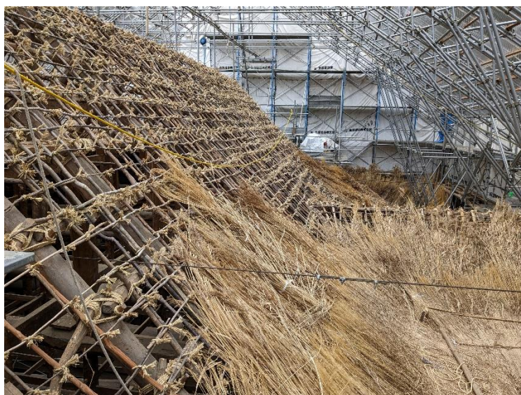
普門院本堂屋根の施工状況
