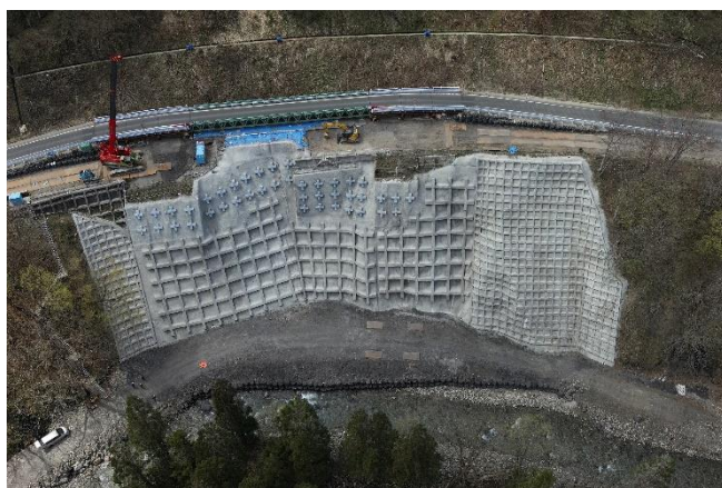
令和６年４月２０日片側交互通行による交通開放状況
