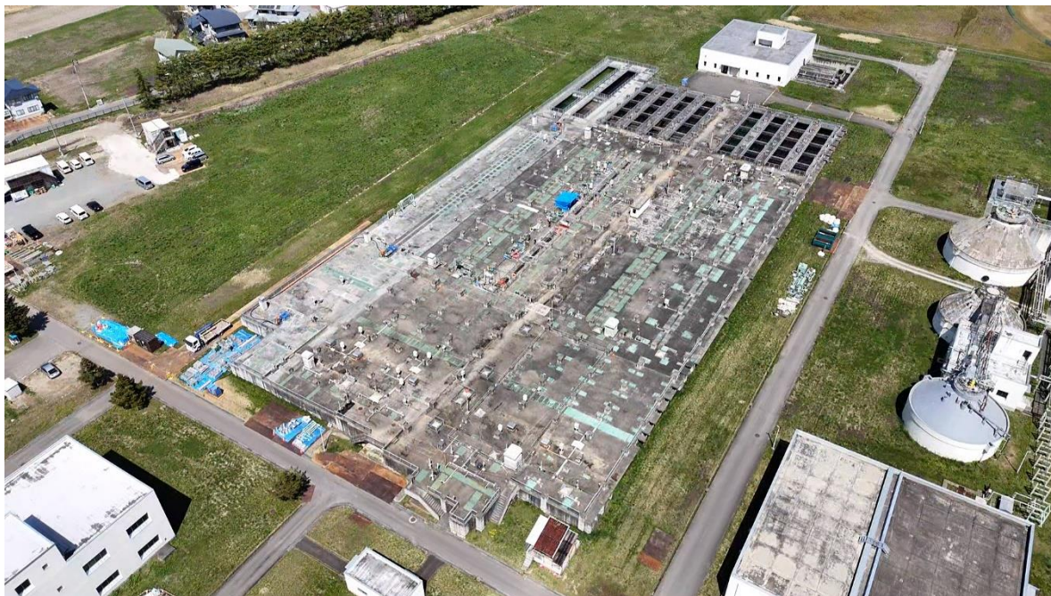
早期改築が求められる米沢浄水管理センターの処理施設
