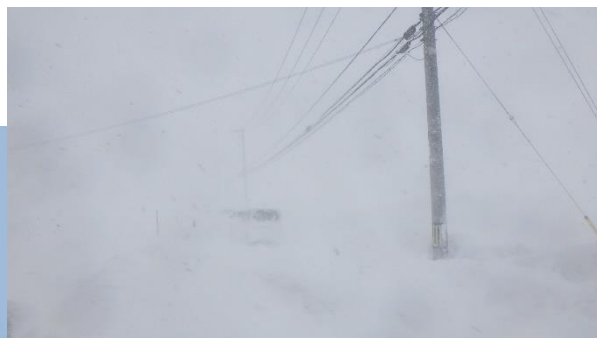
早期着工が求められる一般県道万世窪田線の防雪柵整備
