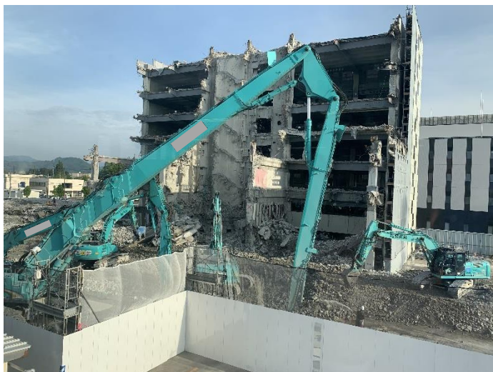
令和4年度に解体した米沢市役所旧本庁舎
