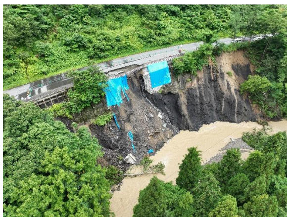
令和４年８月３日からの豪雨による被災状況
