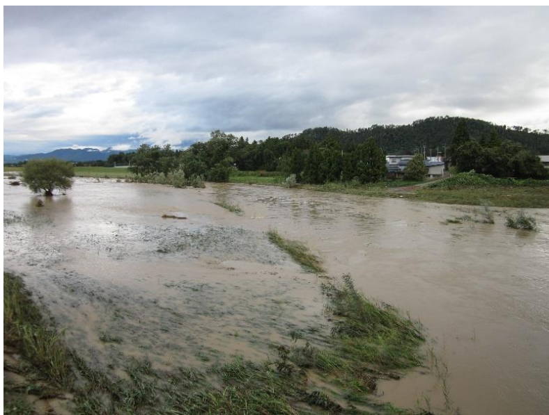
最上川の無堤区間（令和元年10月12日から10月13日の台風19号の影響による増水。新田橋付近）
