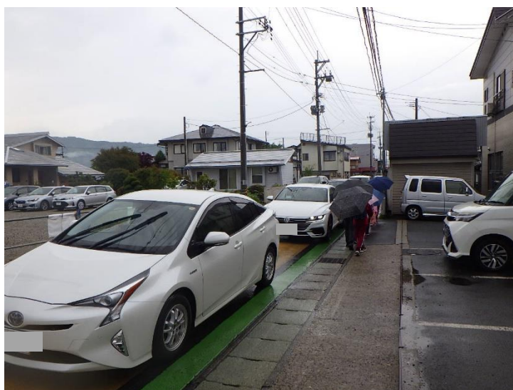
早期の拡幅整備が求められる一般県道板谷米沢停車場線（福田町区間）
