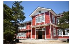
旧長井小学校第一校舎
