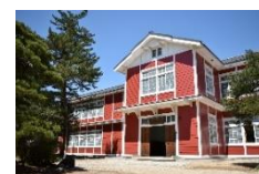
旧長井小学校第一校舎
