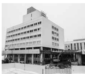
▲解体工事が進む旧庁舎
