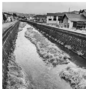
▲土砂が堆積した堀立川
