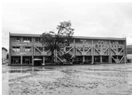
▲長寿命化対象の北部小学校校舎
