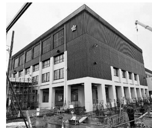
▲建設工事中の南成中学校
