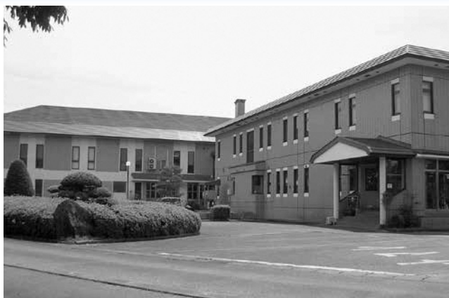
▲解体予定の米沢クリーンセンター
