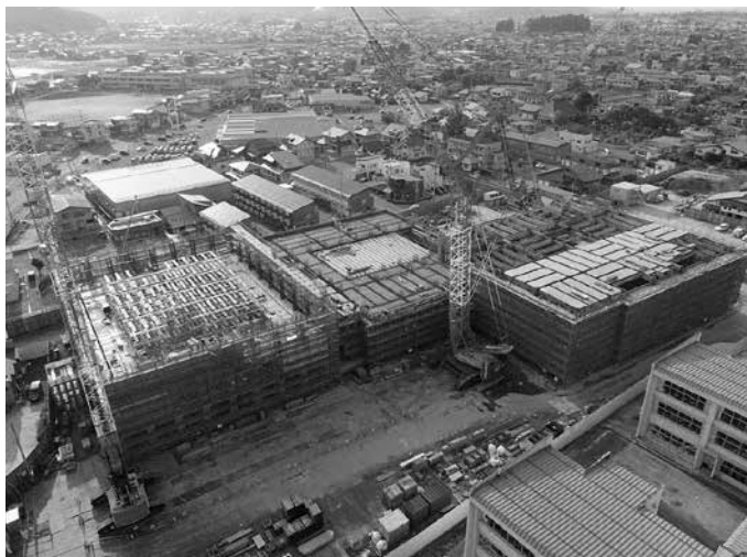
▲建設工事中の南成中学校
