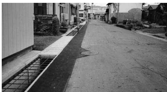
福田町2丁目地内の流雪溝
