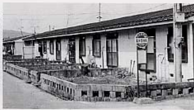
建て替えを計画している塩井町市営住宅
