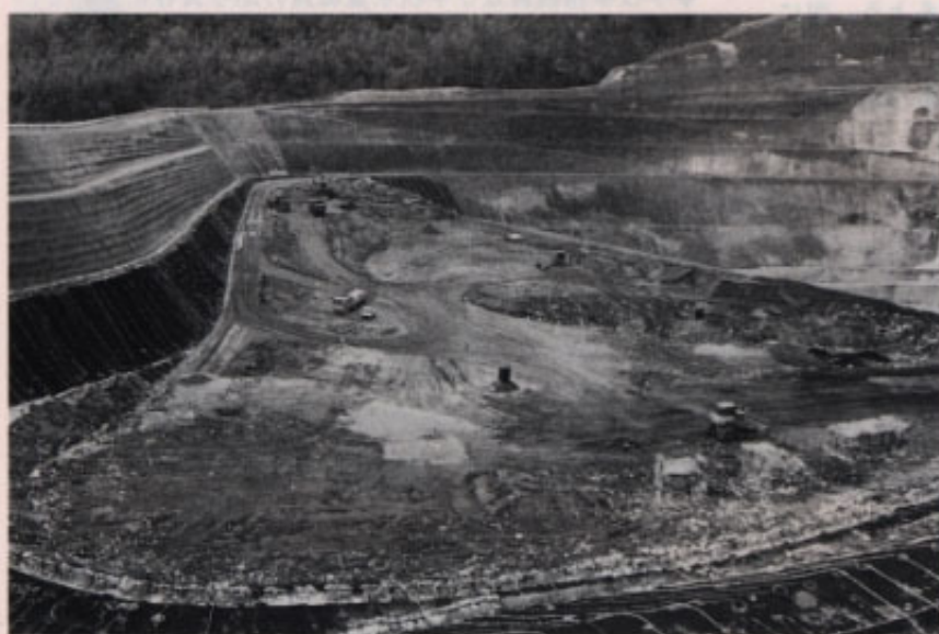
板谷最終処分場
