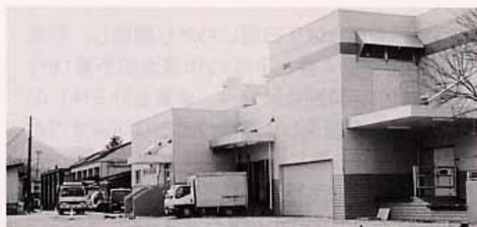
増改築がなされた食肉センター
