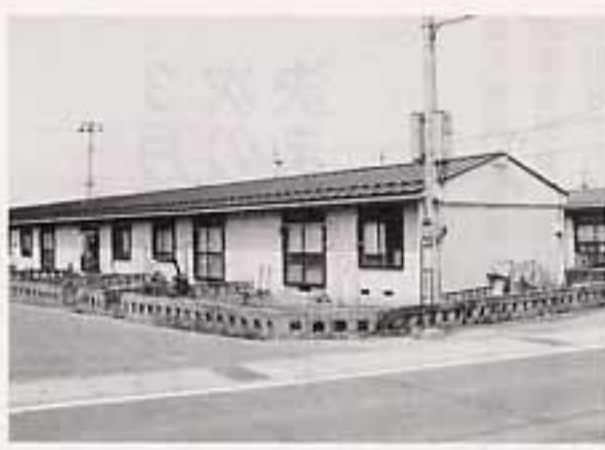
高齢者向け対応が望まれる市営住宅 塩井町団地
