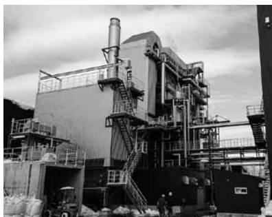
▲米沢南工業団地内の木質バイオマス発電所
