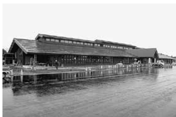
▲建設中の「道の駅米沢」
