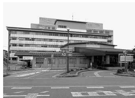
▲経営形態の変更を進めている市立病院
