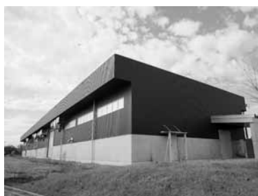
▲蓄電デバイス開発研究センター （オフィス・アルカディア内）
