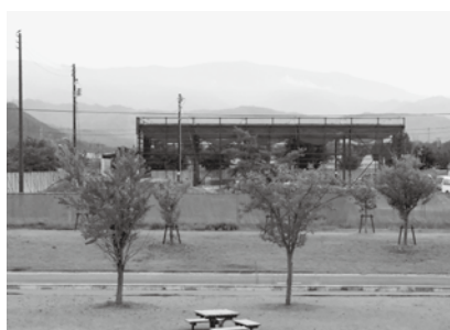
オフィス・アルカディアに建設中の蓄電デバイス研究開発センター
