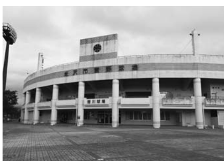
老朽化の進むスポーツ施設の早期改修を!
