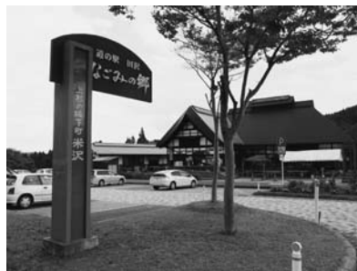
急速充電器の設置が予定されている「道の駅田沢」
