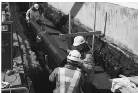
循環ポンプシステムによる流雪溝整備工事の様子
