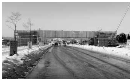
整備が進められている東北中央自動車道（仮称）米沢IC～米沢北IC間
