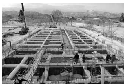
新校舎の建設が着々と進められている
