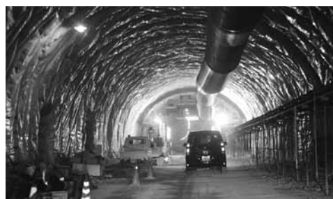
LED照明を使用する予定の 栗子トンネルの施行状況
