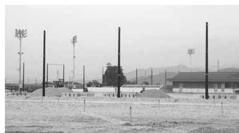
10月末完成予定の『人工芝サッカーフィールド』の工事の様子
