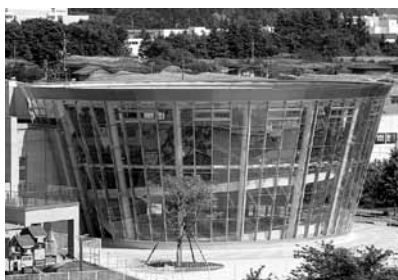
東根市総合保健福祉施設『さくらんぼタントクルセンター・けやきホール』
