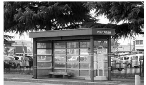
夏の太陽、雨、風をしのげる屋根付き バス停の早期設置が望まれる
