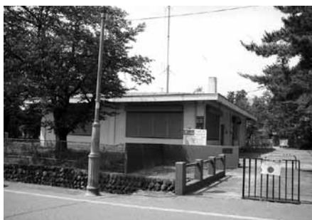
老朽化が進む、米沢ラジオ中継放送所
