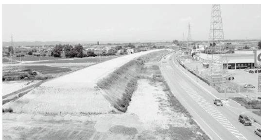
整備が進む東北中央自動車道 (米沢北インターチェンジ付近)
