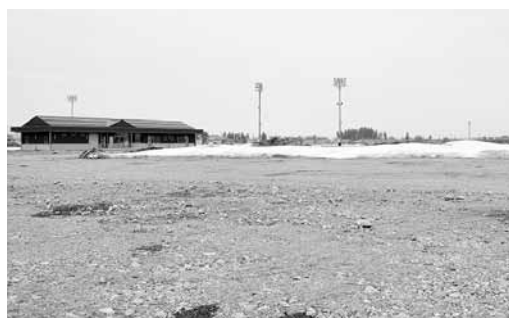
平成24年10月に完成予定の人工芝サッカー場用地
