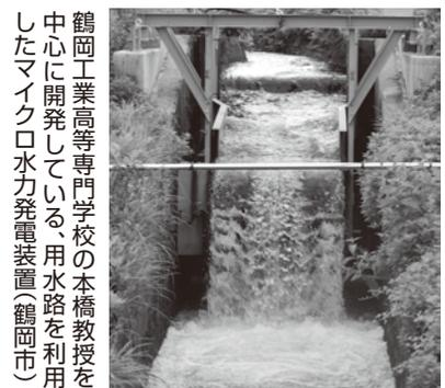
鶴岡工業高等専門学校の本橋教授を中心に開発している、用水路を利用したマイクロ水力発電装置(鶴岡市)
