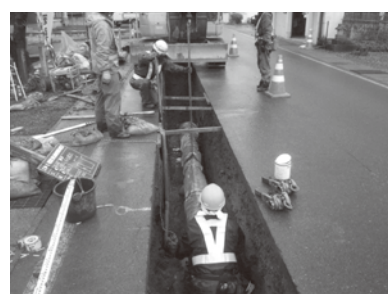
配水管布設替工事の様子
