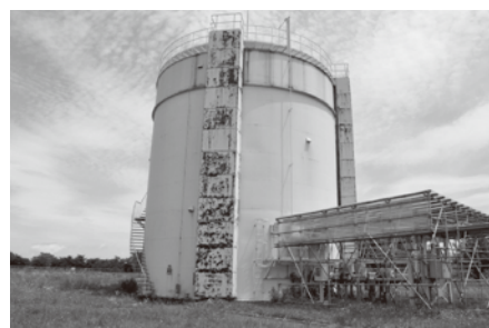
米沢浄水管理センターの汚泥消化設備(ガスタンク)
