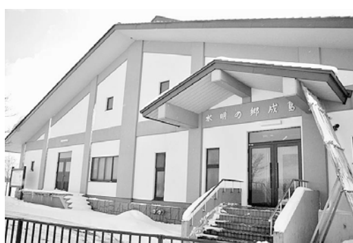
成島地区農業集落 排水（下水）処理施設
