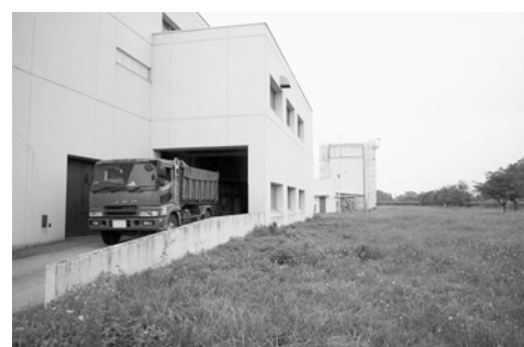
現在の汚泥処理棟と汚泥ホッパー増設予定地
