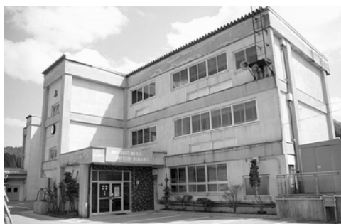
耐震改修を待つ関根小学校
