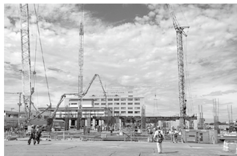
▲新市立病院の建設現場
