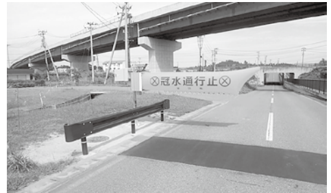
▲国道13号アンダーパスに設置されたエア―遮断機
