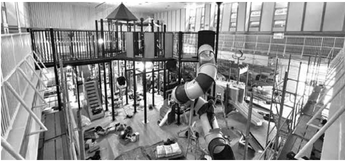
▲建設中の屋内遊戯施設
