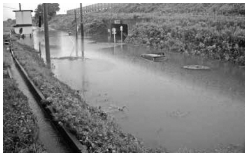
▲昨年の大雨で浸水被害のあった塩井町塩野のアンダーパス付近
