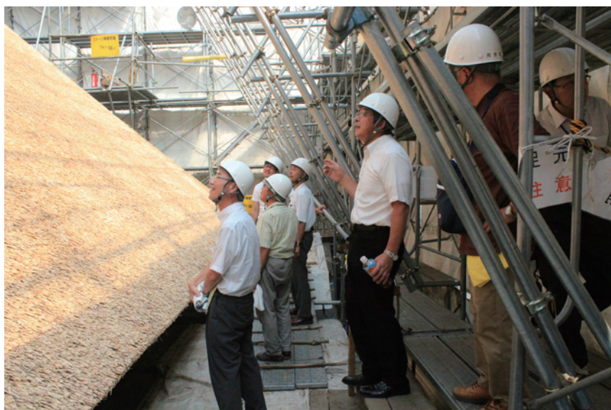
普門院庫裏保存修理工事視察風景
