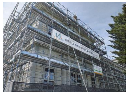
▲現状調査用に組まれた足場
