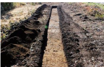
▲試掘トレンチ
