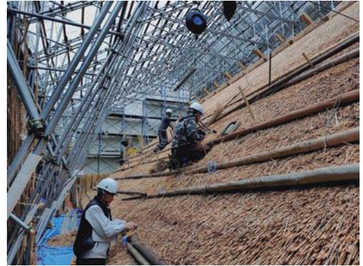
▲保存修理工事が進む普門院本堂
