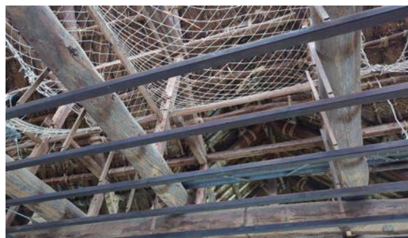
▲保存修理工事が進む普門院本堂
