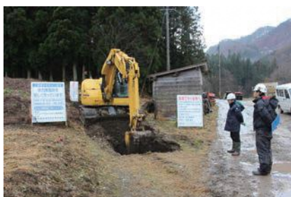
▲大平 c 遺跡工事立会状況
