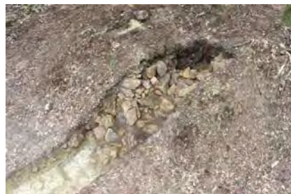
▲碎石の検出状況（北西から）
