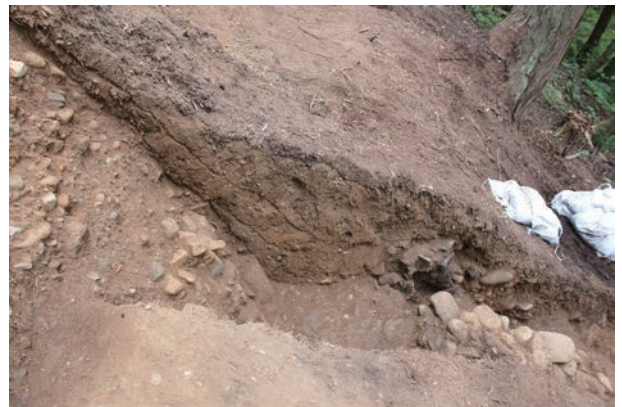
▲ E-1 区 切岸と段丘礫層（東から撮影）
