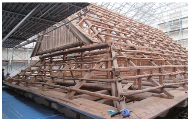
▲普門院本堂（解体工事を行った屋根）
