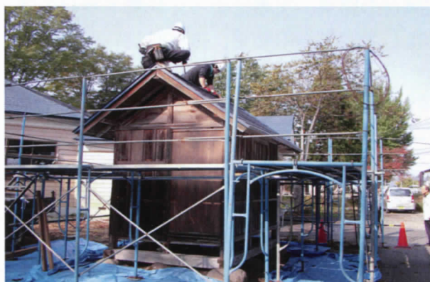
▲行屋Ⅱ号棟保存修理工事の様子（修理前）
