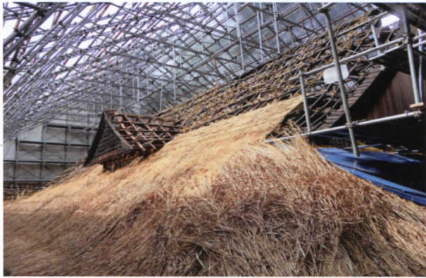
▲普門院庫裏屋根工事
