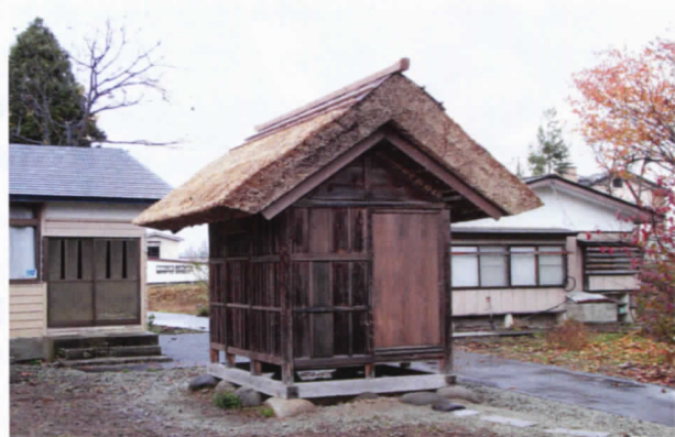
▲竣工した行屋Ⅱ号棟
