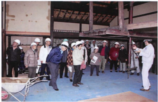
▲普門院庫裏保存修理工事現場見学会
