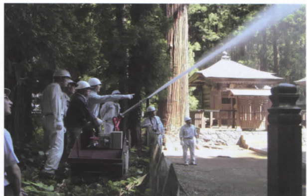
▲消化設備復旧後の放水訓練の様子
