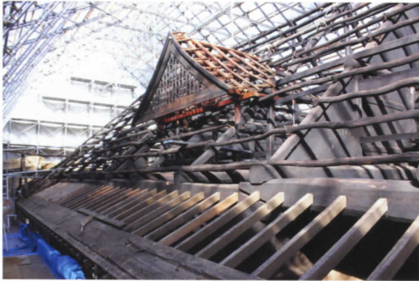
▲普門院庫裏屋根の骨組
