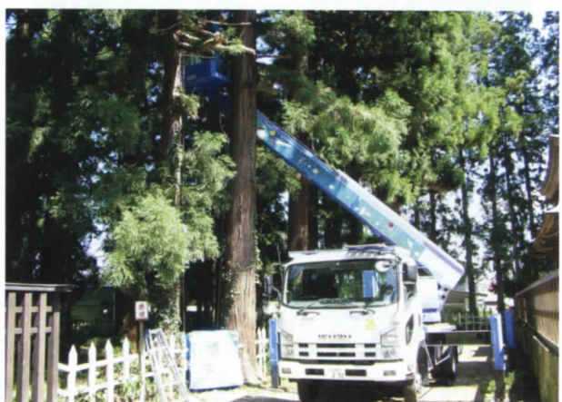
▲避雷針設置作業
