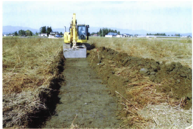
▲石田遺跡分布調査風景 (重機を使用したトレンチ調査)
