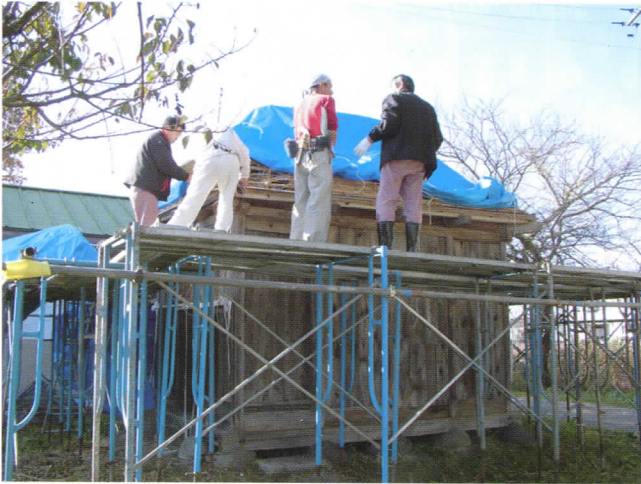
▲行屋 2号棟修復状況
