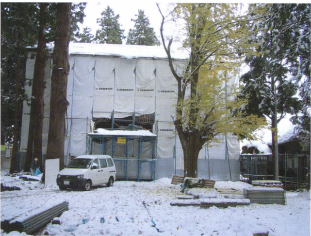
▲羽黒神社本殿工事覆屋
