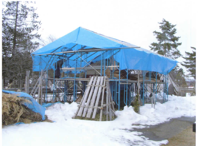
▲行屋 3号棟修復状況
