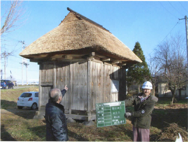
▲行屋 2号棟完成検査
