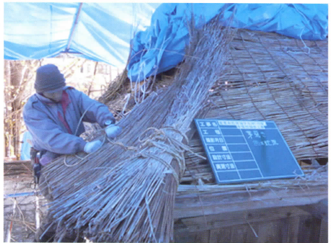
▲行屋 2号棟茅葺状況
