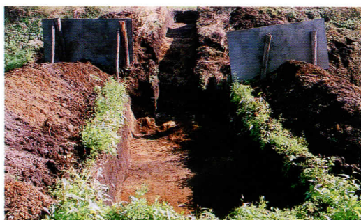
西側トレンチ
