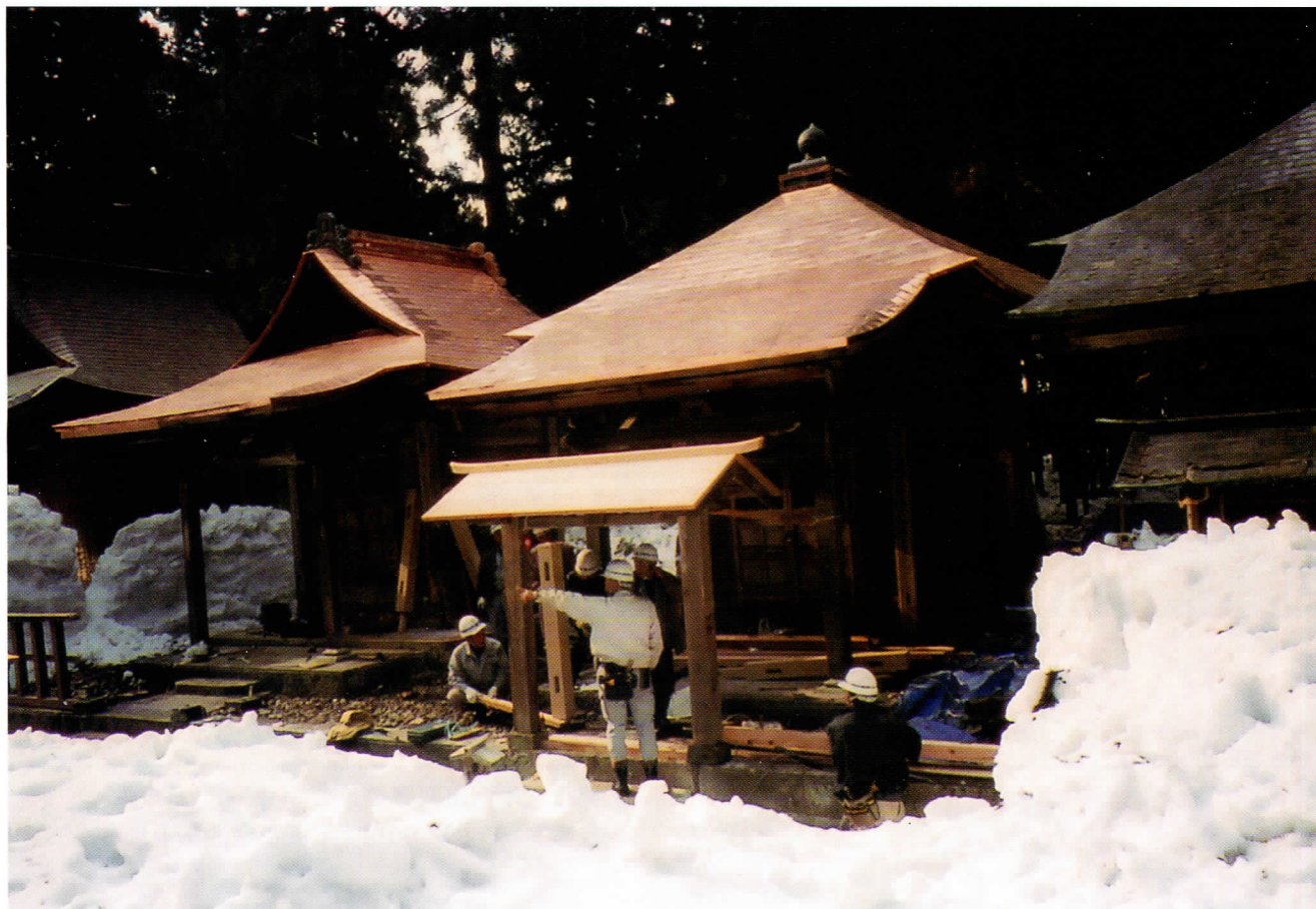
6代・8代の解体修理風景（中央の2棟 左が6代、右が8代）
