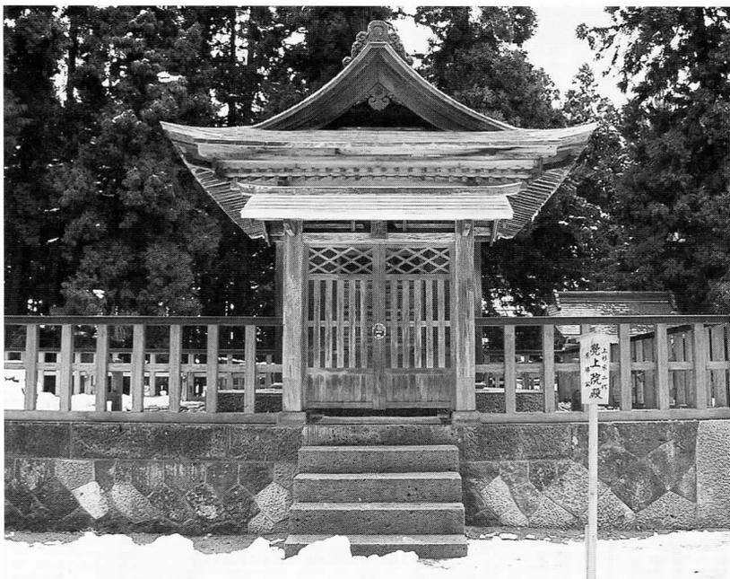
国庫、県費、市費を導入した補助事業として実施。破損状況……建物は柱の不同沈下及び傾斜が著しく外部から支えの柱及び筋違いを取り付けて建物の倒壊を防いでいる。
