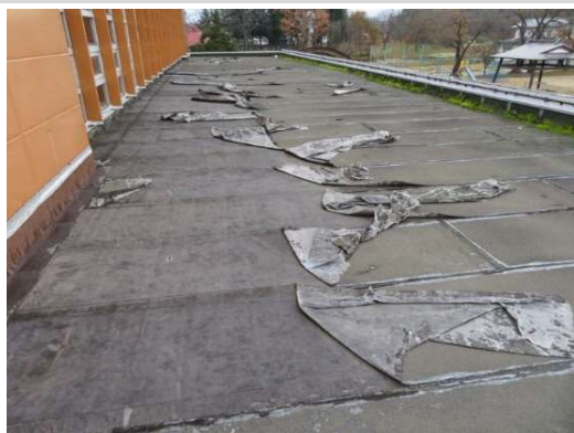
屋根（屋上防水）
