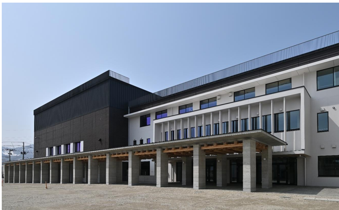
米沢市立南成中学校（令和 7 年竣工）
