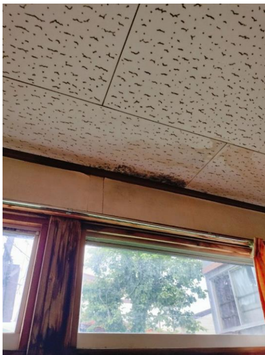
元ガイダンス教室：天井の雨漏り
