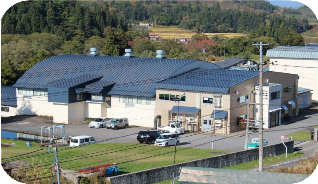
令和7年度に廃止が予定されている館山浄水場
