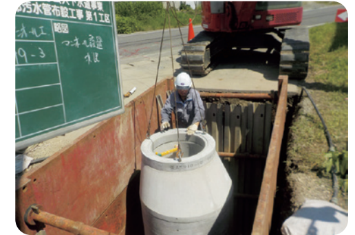
汚水管渠の新設 延長約399.4m
