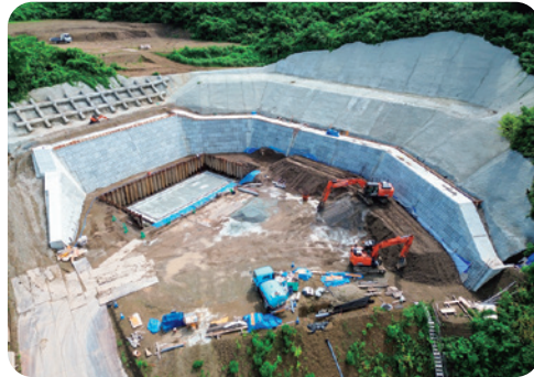
法(のり)面保護・大型擁壁・土留め工事
