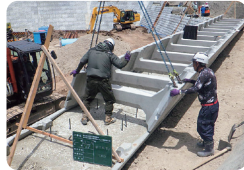
大型ブロックを積み上げて擁壁を作っています
