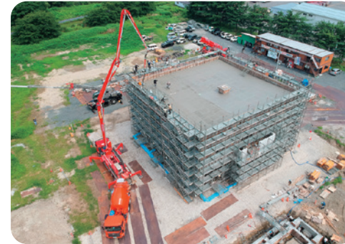
し尿受入施設建設工事
