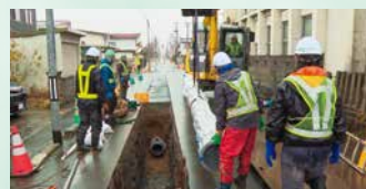
地震に強い水道管へ交換しています
