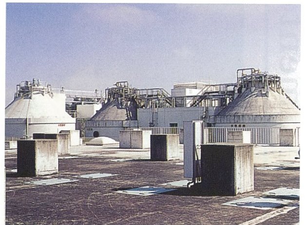
汚泥消化タンク
