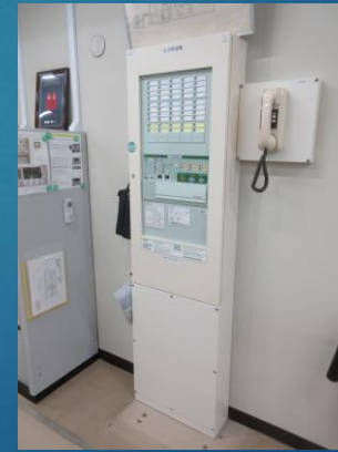
火災受信機設置
