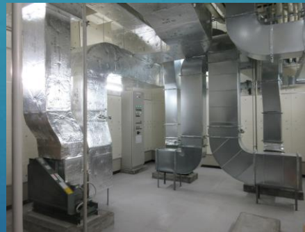
吸排気設備設置
