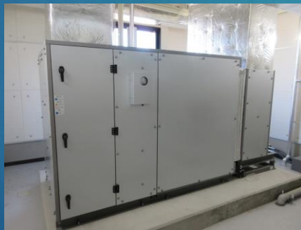
空調機室内機設置
