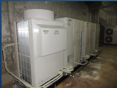
空調室外機設置
