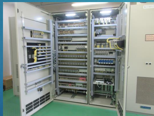
遠方監視制御設備の更 新(内部)
